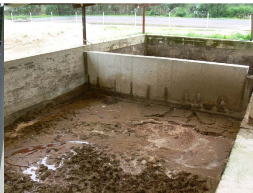
Fotografia 3.14 – Leitos de secagem (desidratação de lamas)
