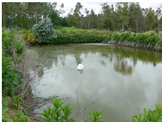
Fotografia 6.1 – Lagoa final de armazenamento do efluente tratado produzido pelo matadouro CARNES LANDEIRO pertencente à AGROLANDEIRO
