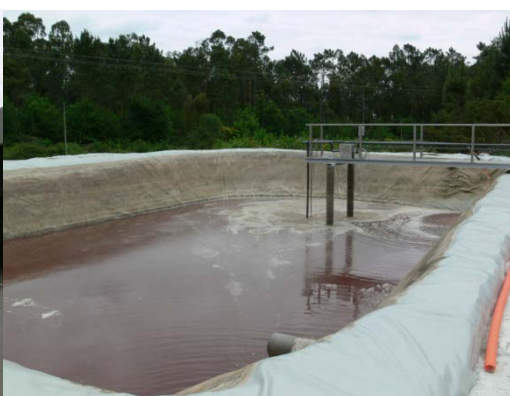
Fotografia 3.12 – Bacia impermeabilizada
